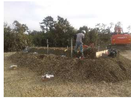
写真-5 盛土施工とセンサ設置
