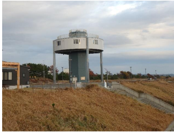
写真-1 津波避難タワー（福田漁港）
